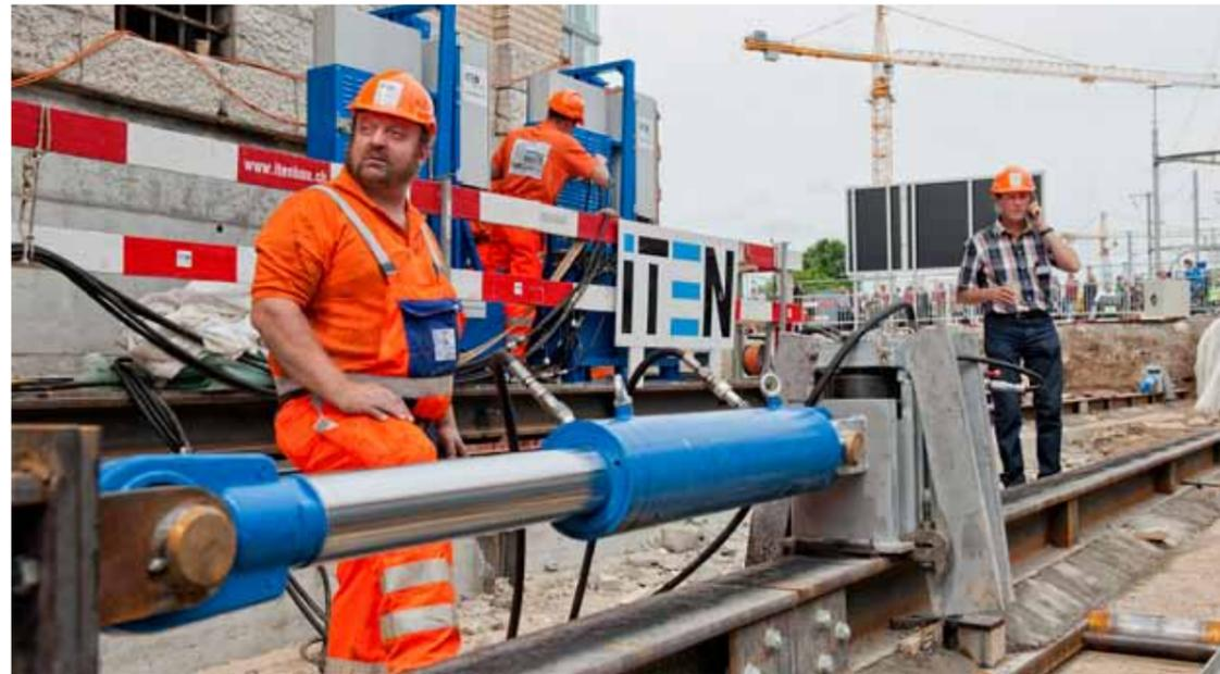
Mit Hydraulikpressen, die an den Gleisen angelegt werden, schieben die Ingenieure das Gebäude Stück um Stück an seinen neuen Standort.
