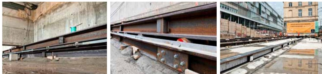
Blick unter das Gebäude: Die Kellerwände wurden betoniert und auf die Verschubbahn gestellt (Bild links). – Unterhalb der Gleise befindet sich die Betonplatte, die mit Pfählen fundiert wurde (Bild Mitte). – Der Massstab am Gleis zeigt, wie viele Meter noch zu absolvieren sind (Bild rechts).
