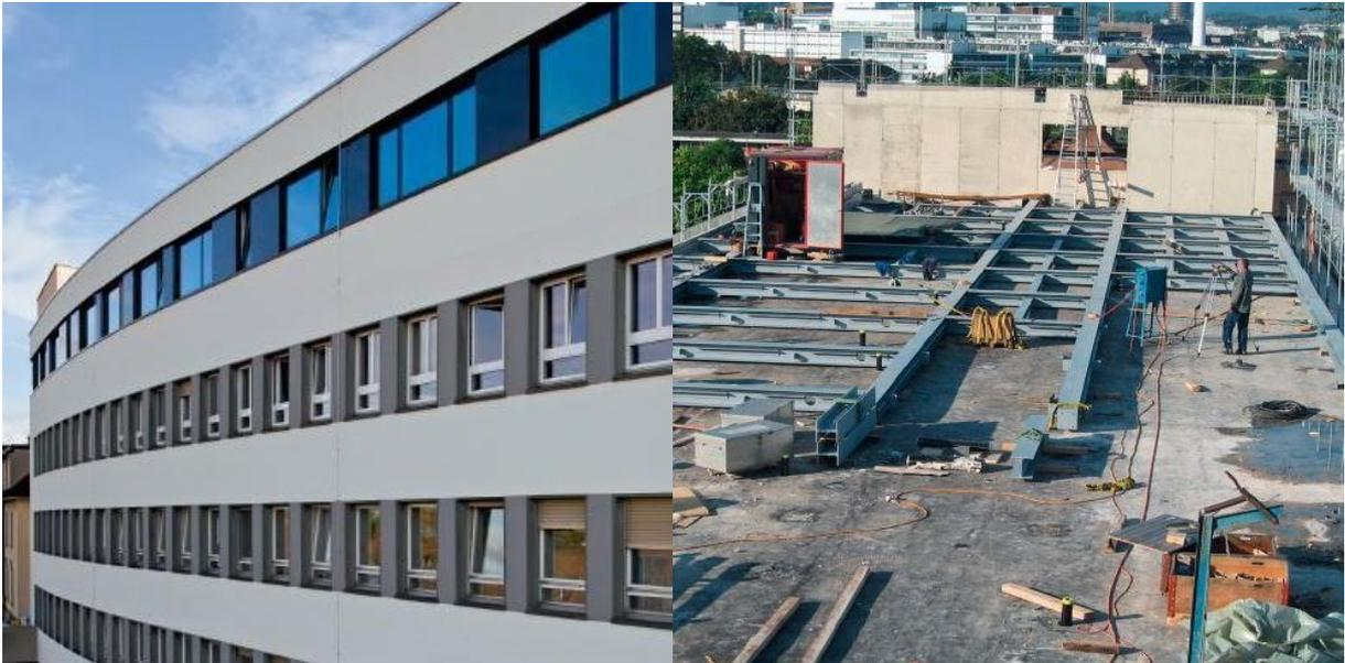
Gleichzeitig zum Neubau der Radioonkologie und der Tiefgarage wurde das Bettenhaus aufgestockt. Der Neubau des 5. Obergeschosses stellte für den Architekten und den Bauingenieur eine grosse Herausforderung dar. Die Tragkonstruktion sollte so leicht als möglich sein um die Verstärkungsmassnahmen in den darunterliegenden Geschossen, die während der Bauzeit genutzt wurden, so klein als möglich zu halten. Aus diesem Grund wurde das Traggerippe aus einer Stahlkonstruktion erstellt.
