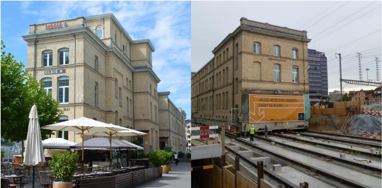
Das Verwaltungsgebäude der ehemaligen Maschinenfabrik Oerlikon (MFO) musste wegen der Durchmesserlinie der SBB um 60 Meter verschoben werden. Bei der Umsetzung der Verschiebung waren vier Parteien involviert, die Stadt Zürich, die ABB, die SBB und die SPS. Vor der Verschiebung mussten am neuen Standort die Ver- und Entsorgungsleitungen sowie die Tiefgaragenzufahrt vom Cityport umgelegt resp. neu verlegt werden.
